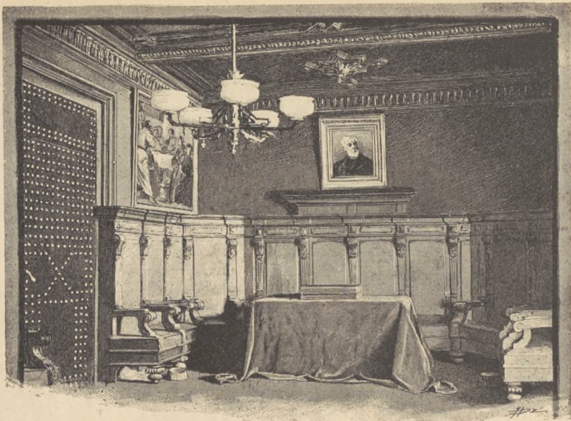
Salón de Juntas.
