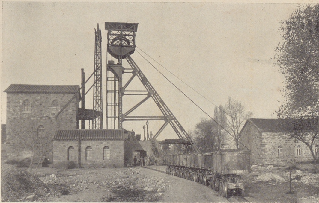
Uno de los varios aspectos que ofrece la zona minera, con la máquina elevadora y vagonetas para el transporte del mineral.
