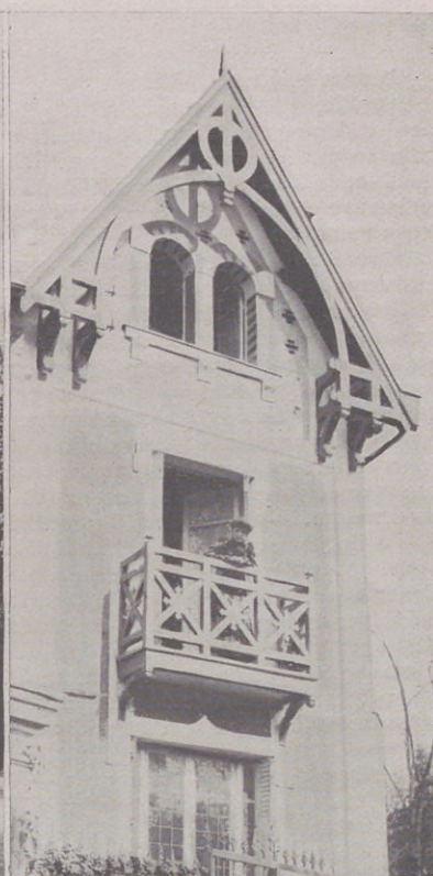
DÉTAIL DE LA FAÇADE
