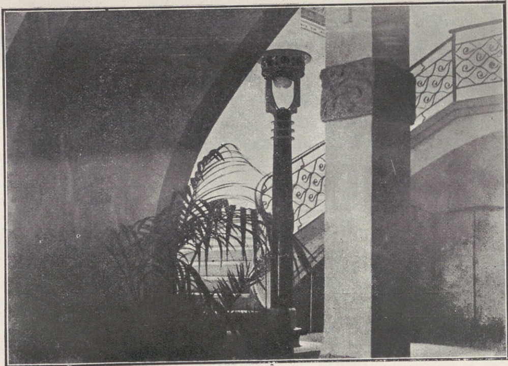
Arranque de la escalera principal.
