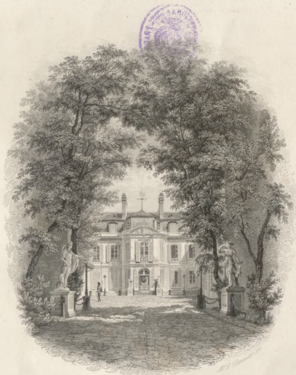
ENTRÉE DE CHATEL AGUADO
