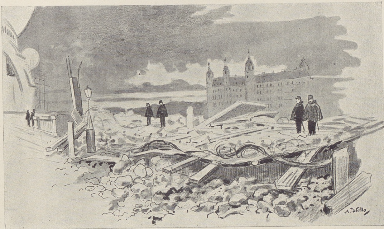
Puente de madera, que conducía á la instalación del GLOBO CELESTE, hundido al peso de los transeúntes
