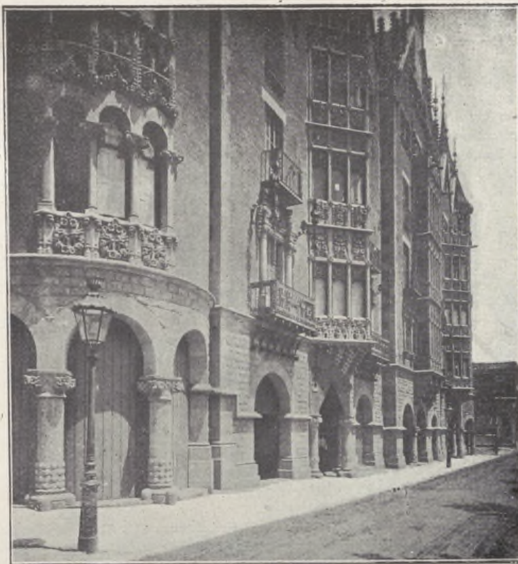
CASA DE ALQUILER EN LA GRAN VIA DIAGONAL. — BARCELONA
