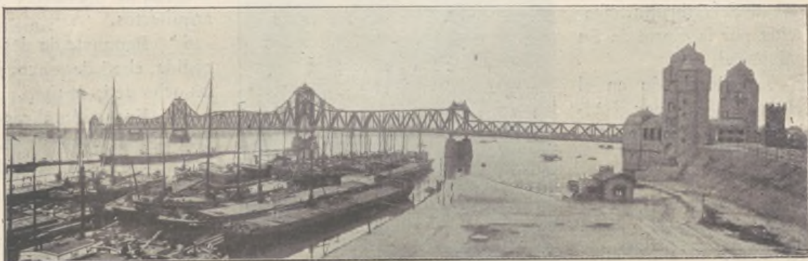
Vista general tomada desde el lado de Ruhrort, del puente sobre el Rhin de Ruhrort a Homberg
