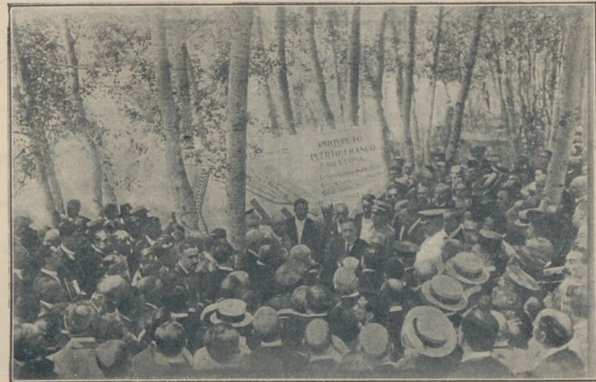
Les autoritats i demés concorrents a l'acte, oint les explicacions que referents a l'emplaçament del Port Franc donà l'arquitecte autor del projecte
