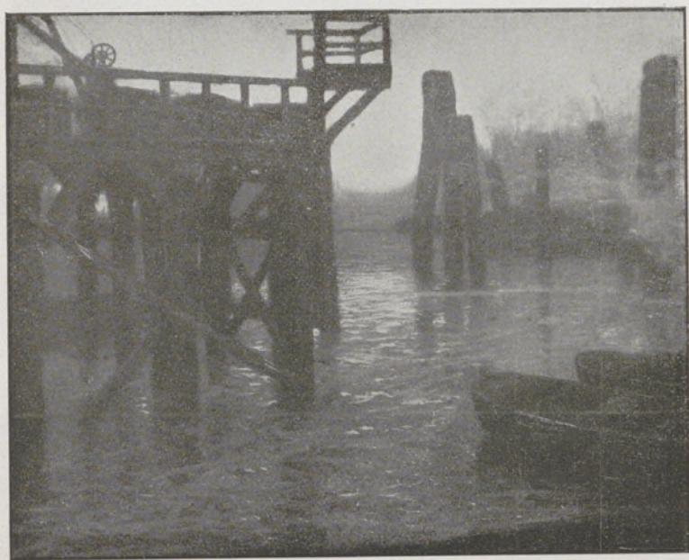
ULMANN (R.-A.). Le wharf (Hambourg) .
