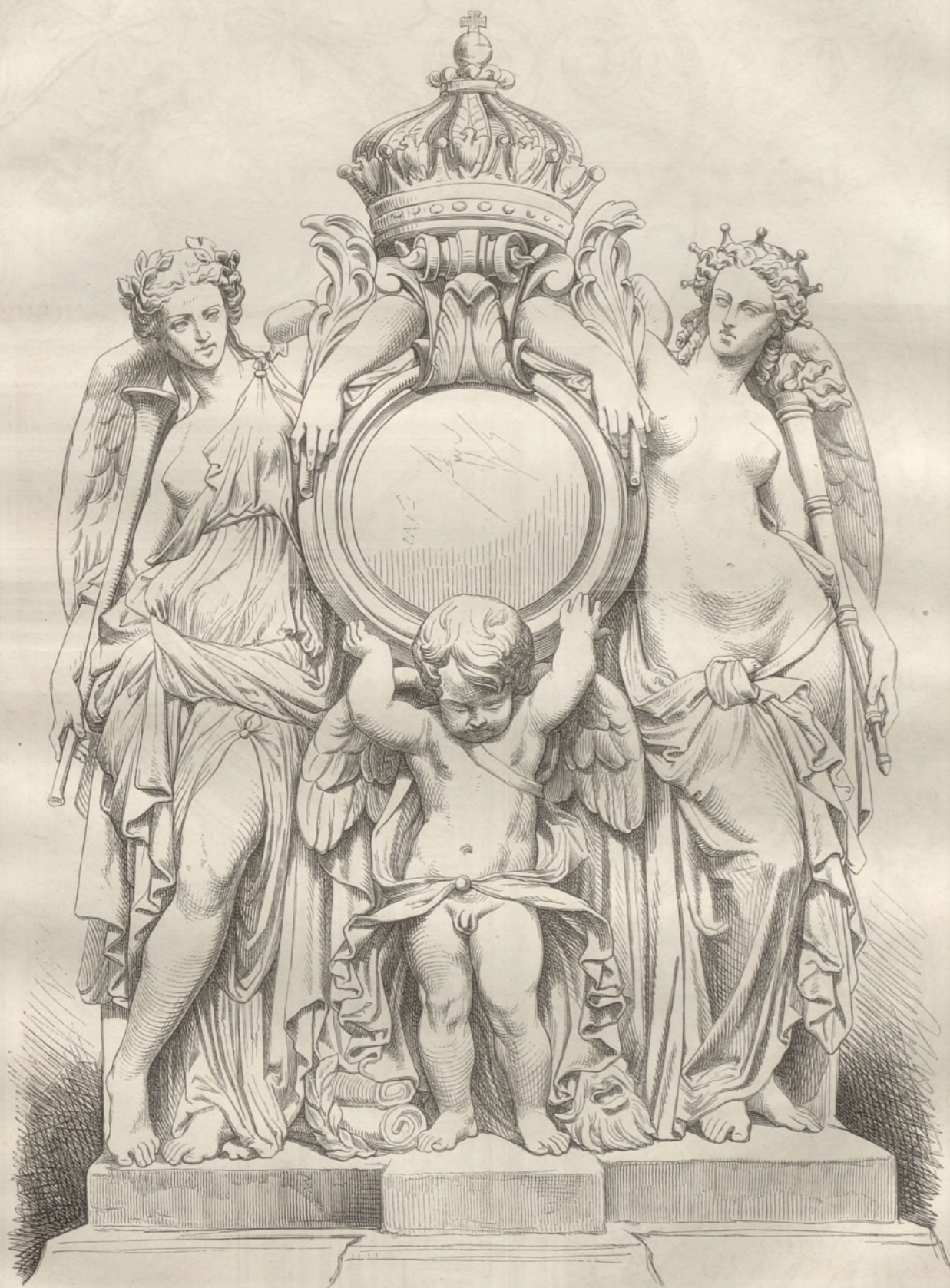
N.º 9.— Remate colocado sobre las columnas pareadas de la fachada principal de la Nueva Gran Ópera de París.
