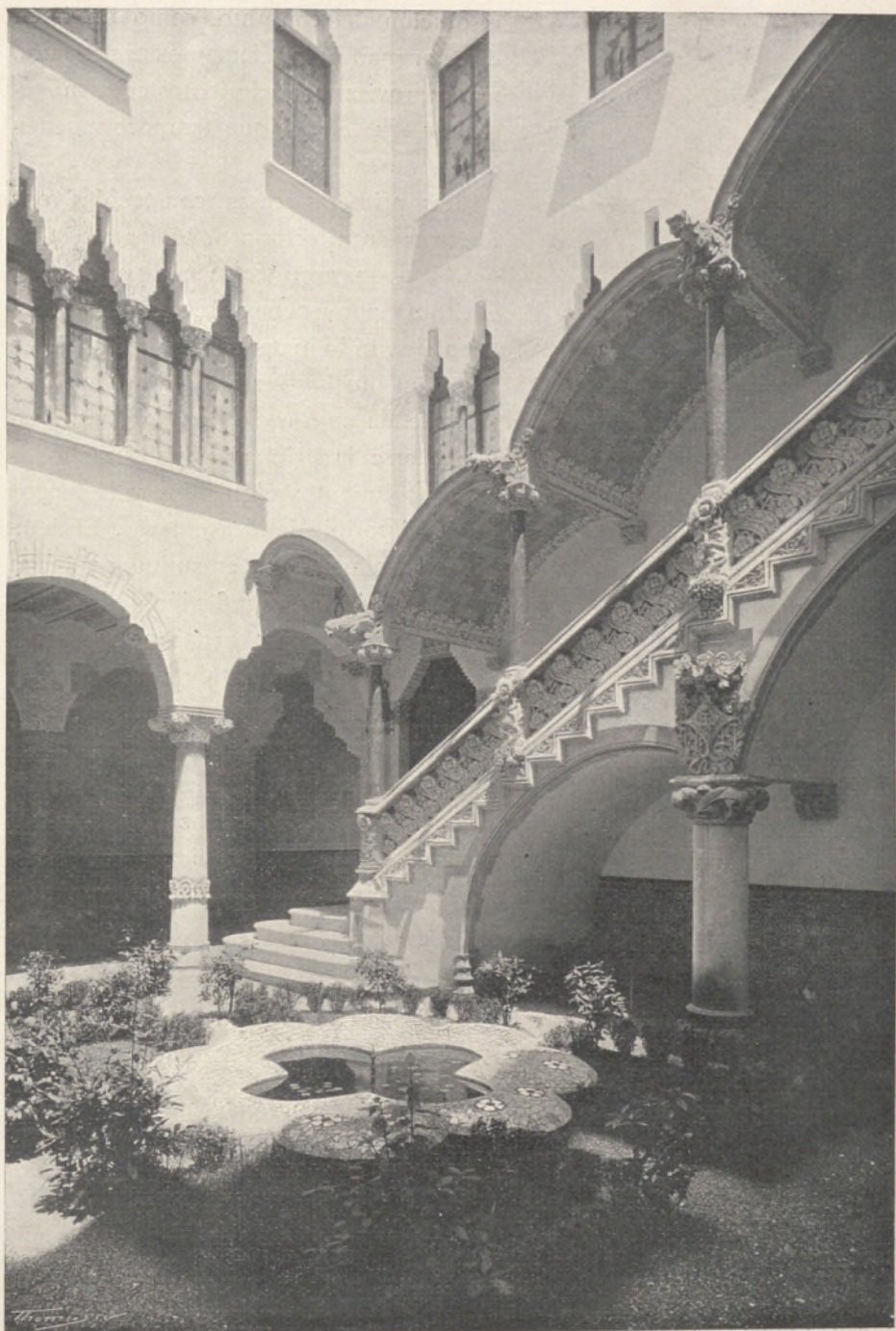
CASA MACAYA. PATIO CENTRAL
