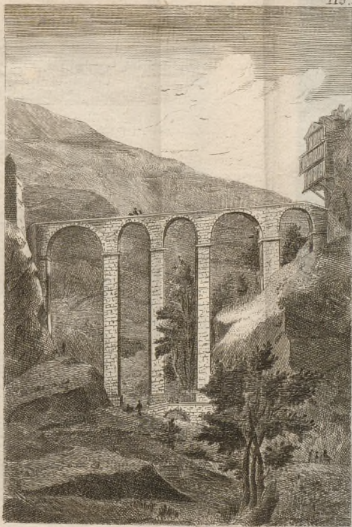
PUENTE DE S. PABLO.
