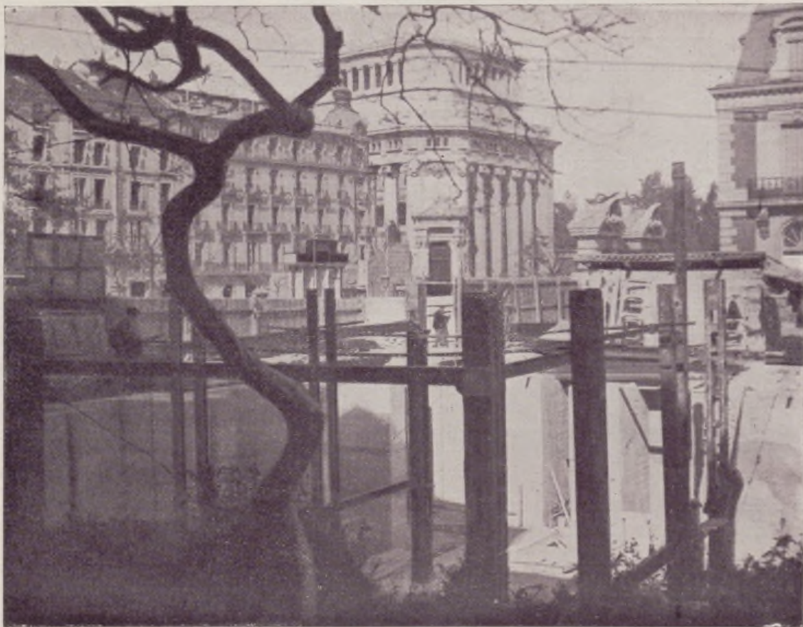
AVANCE DE LAS OBRAS EN 15 DE ABRIL DE 1922
