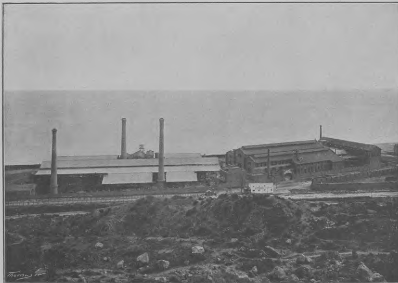
VISTA DE LOS TALLERES DE LA SOCIEDAD EN LA CARRETERA DE CASA ANTÚNEZ (BARCELONA)
