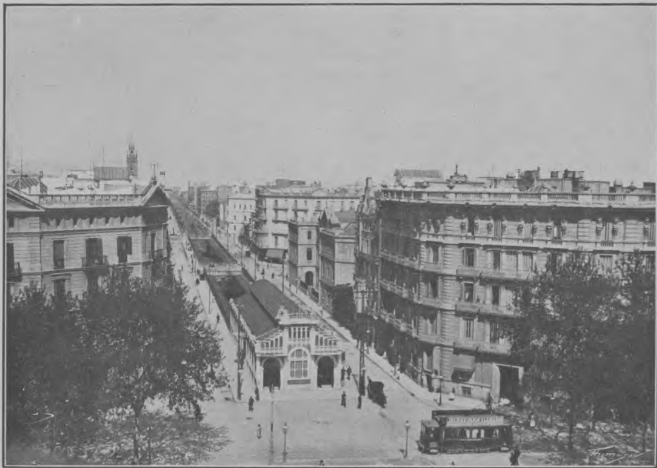
Apedero del Paseo de Gracia «» Gare secondaire du Paseo de Gracia
