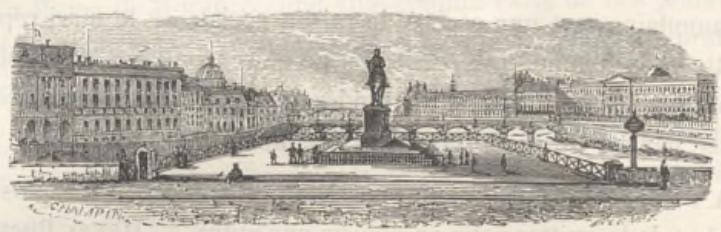
Terre-plein du Pont-Neu.
