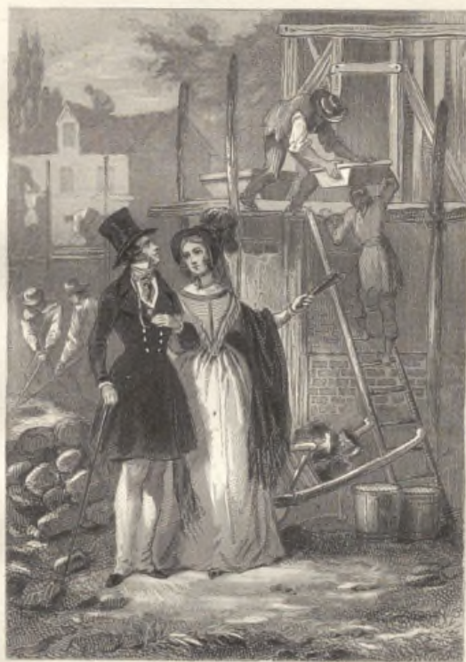
Les maçons étaient à l'œuvre, et des demeures saines s'élevaient pour les protégés d'Adrienne à côté de leurs masures.
