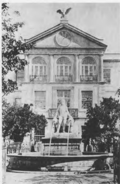
4. Vista del patio de la fábrica El Hércules. Querétaro (México), Museo de la Restauración de la República
