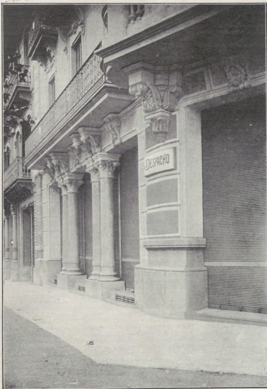
Casa particular en las calles de Bailén y Caspe. — Barcelona
