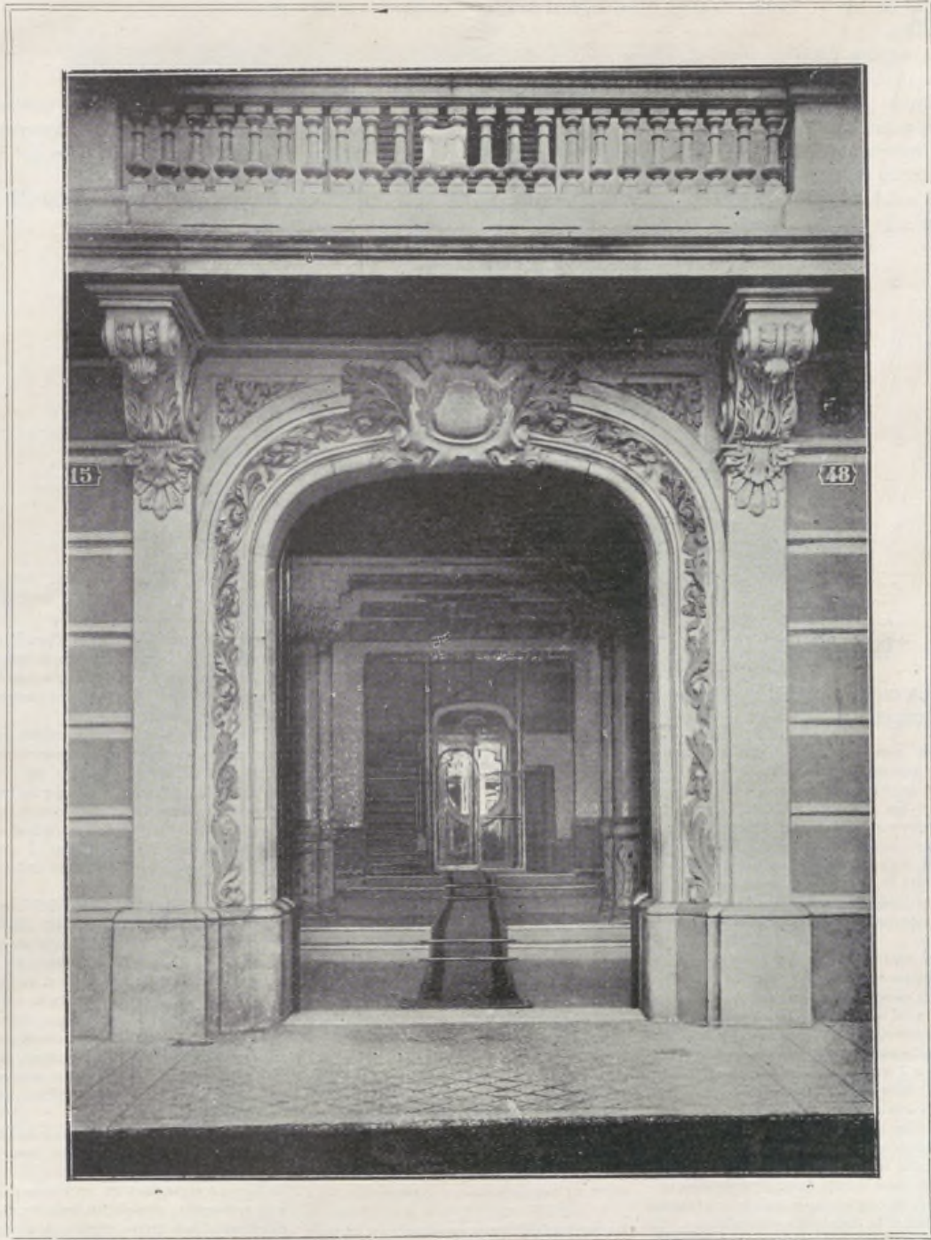
Casa particular en las calles de Bailén y Caspe. — Barcelona
