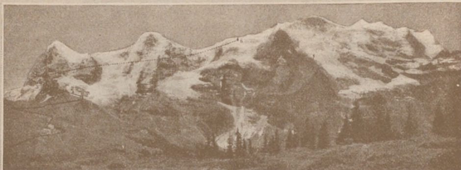
L'estesa del funicular de la Jungfrau que en algun punt penetra en la frontera italiana (fotografia feta a 1,897 metres) 1-2-3-4. Estacions en les vertents del mont Eiger. — 5. Estació d'«El Monjo». — 6. Estació final (Jungfrau)]
