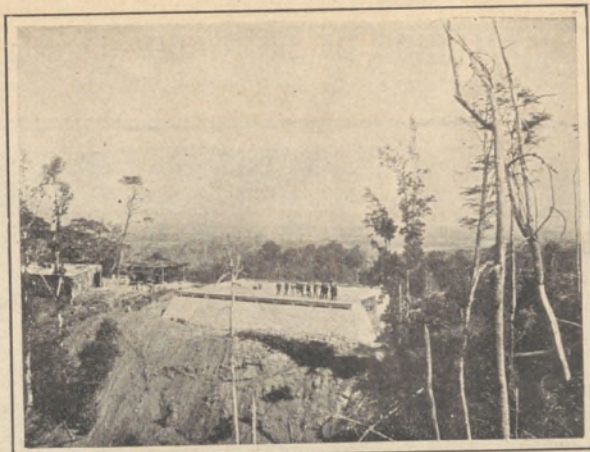
Llancahue. Estanque de agua potable
