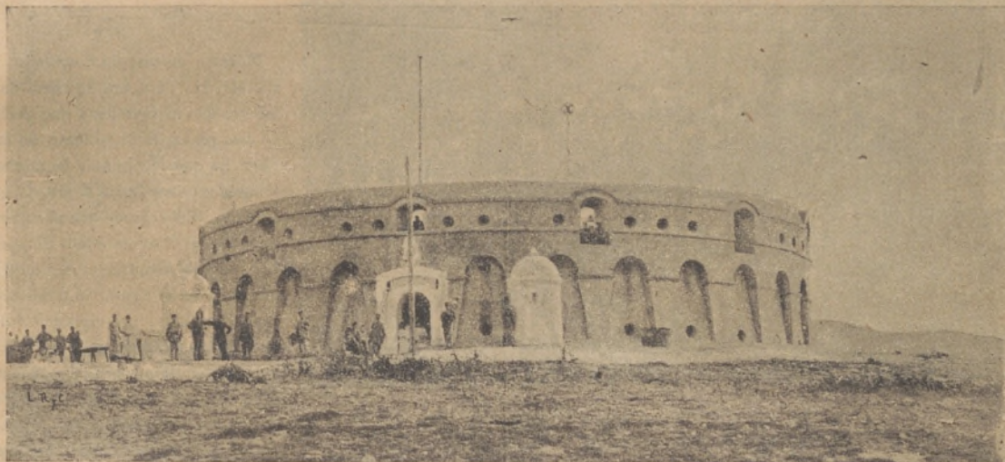
TORRE DE CAMELLOS
