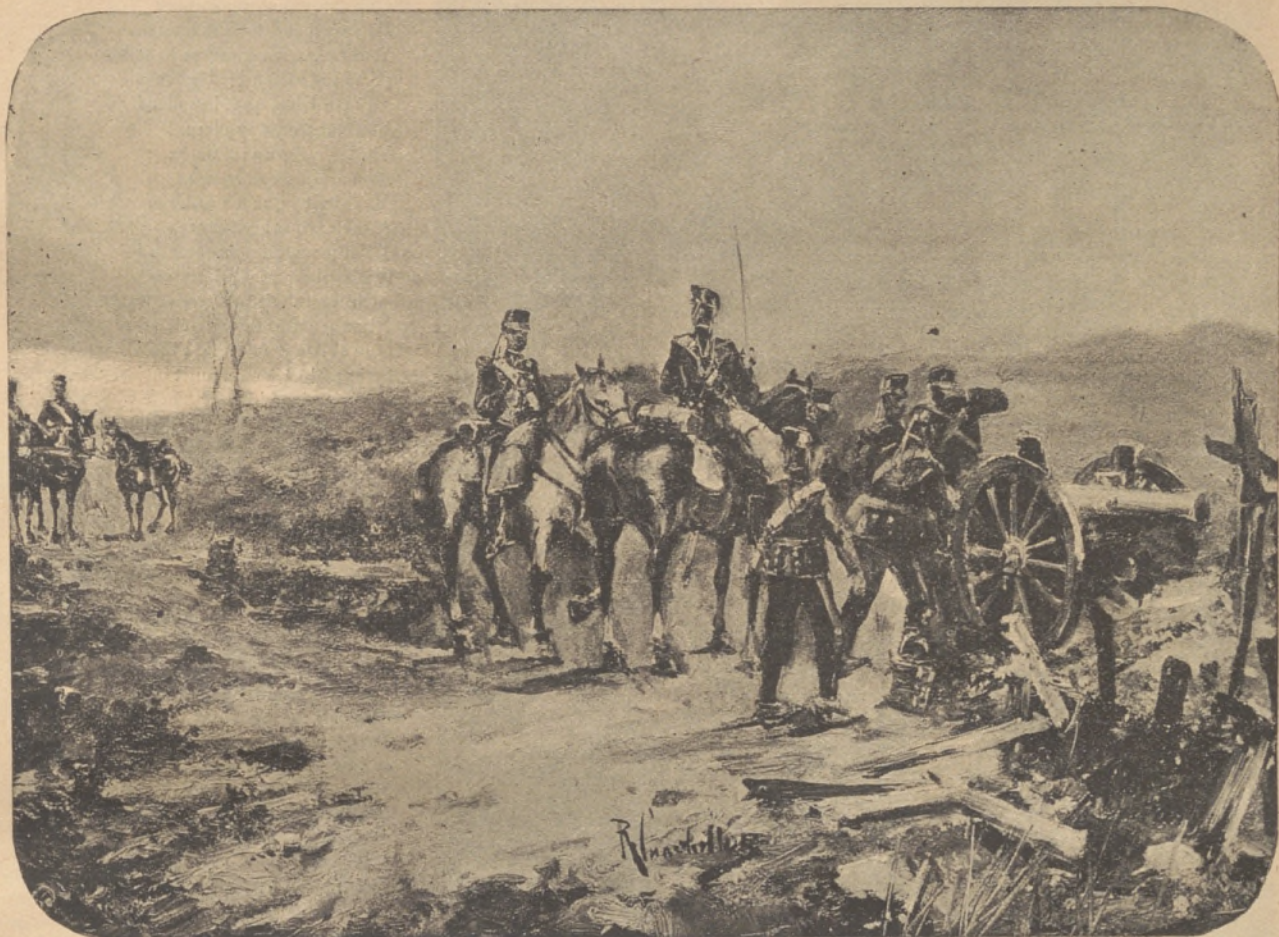
EMPLAZAMIENTO DE UNA BATERÍA
