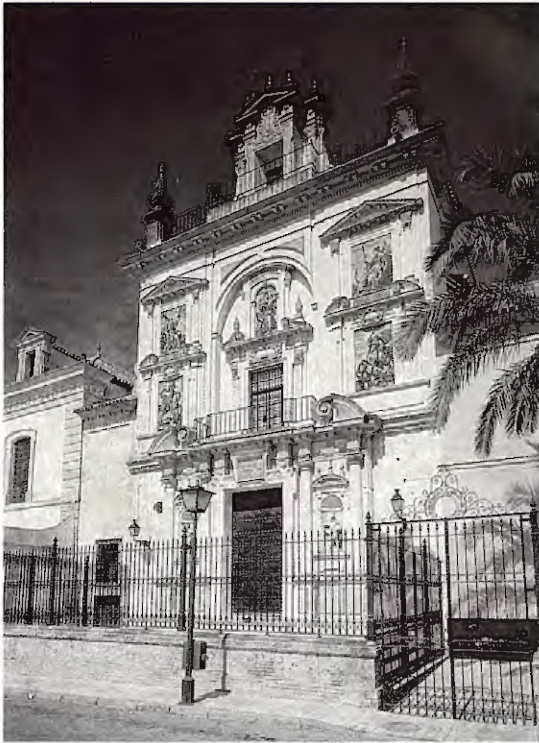
Fig. 20. Sevilla. Hospital de la Caridad. Fachada de la Iglesia.
