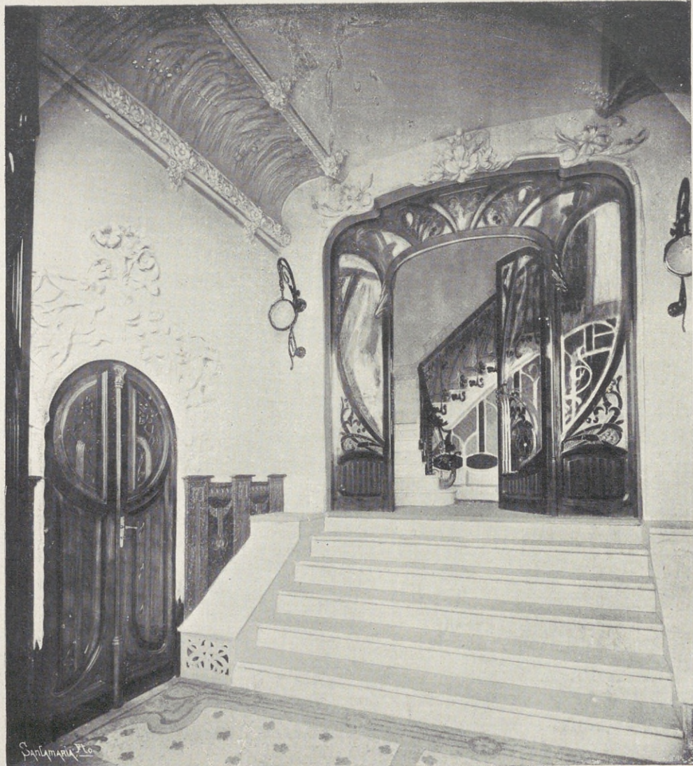
Detalle interior del portal.
