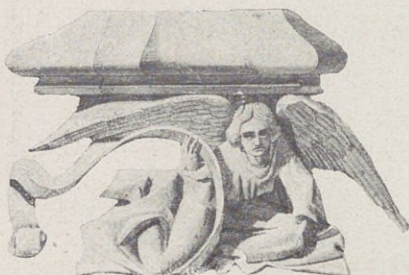
Arranque de un conopio de la fachada del Sur.
