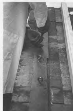
2. Eliminación de los barrotes atornillados que impedían el movimiento de las tablas.
